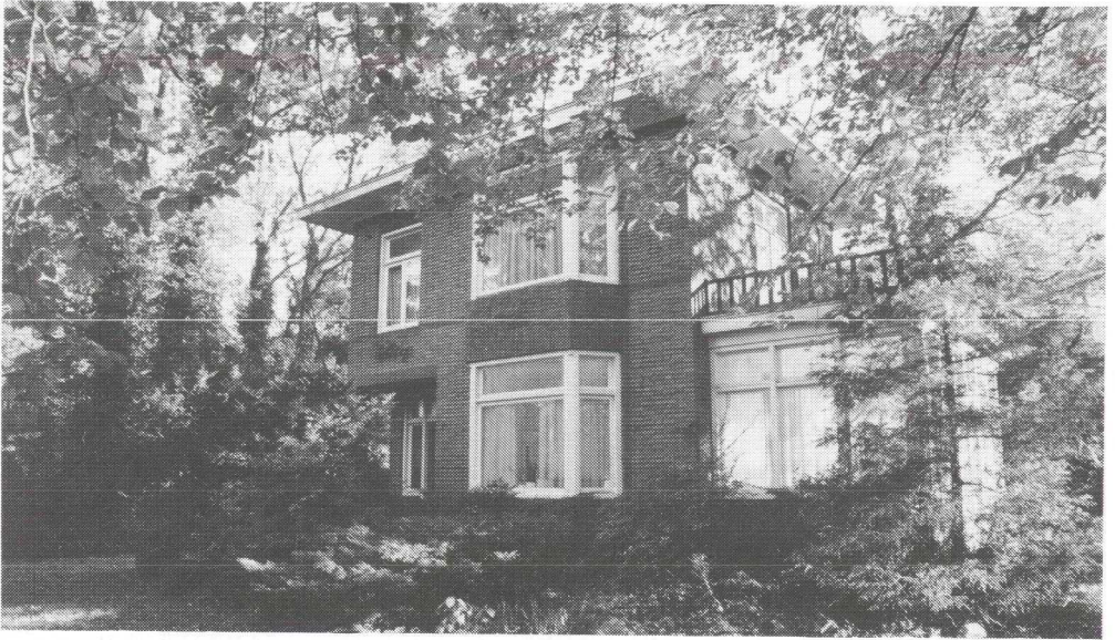
Villa "de Klinge", Amersfoortsestraat 106, gebouwd in 1929, stond schuin tegenover "De meijerij". Het perceel werd in december 1997 gesloopt. (28-10-1997)
